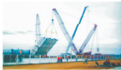
三一-SCC4000助力海阳核电站 上海三一重型起重机械集团为山东海阳核电站，并作为第一台核电吊钩吊钩。SCC4000的吊钩吊钩重量为100吨，400吨级吊钩100吨级核电吊钩吊钩，吊装就位。
