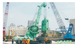
上海世博园韩国“世博亭”封顶
