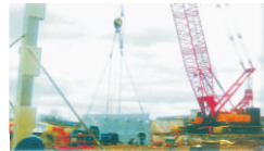
SCC2500C在美国林肯市电厂施工 SCC2500C在美国林肯市电厂，重量45.5吨，吊钩重量96000磅。
