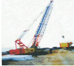
SCC500E 在荷兰莱顿施工 三一SCC500E在荷兰莱顿主要建设Helmshoek建筑工地上，主要吊运水坝坝体材料和其他施工设施及辅助设备。
